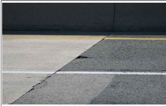
교면포장 상행선 A1측 접속도로 라벨링
